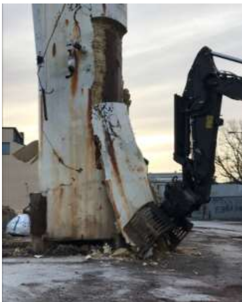
Rivning av CFC-isolerad stålcistern.
