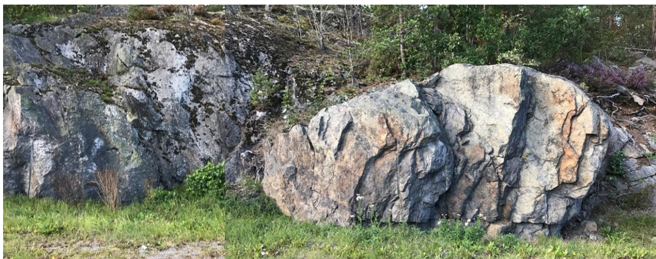
Figur 3: Bergskärning längs med Farmarstigen där uppsprickning längs med foliationen framträder [2]
