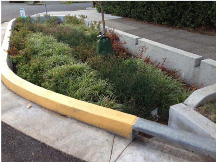
Figur 20. Bildexempel från Portland på nedsänkt växtbädd med träd och andra växter dit dagvatten från väg och trottoar leds. Foto: WRS AB.
