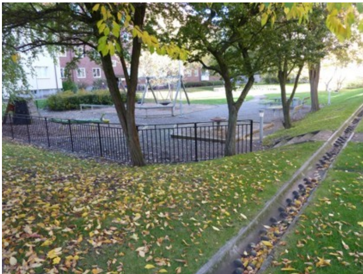
Figur 18. Exempel på utformning av rännor för avledning av takdagvatten. Foto: WRS AB.
