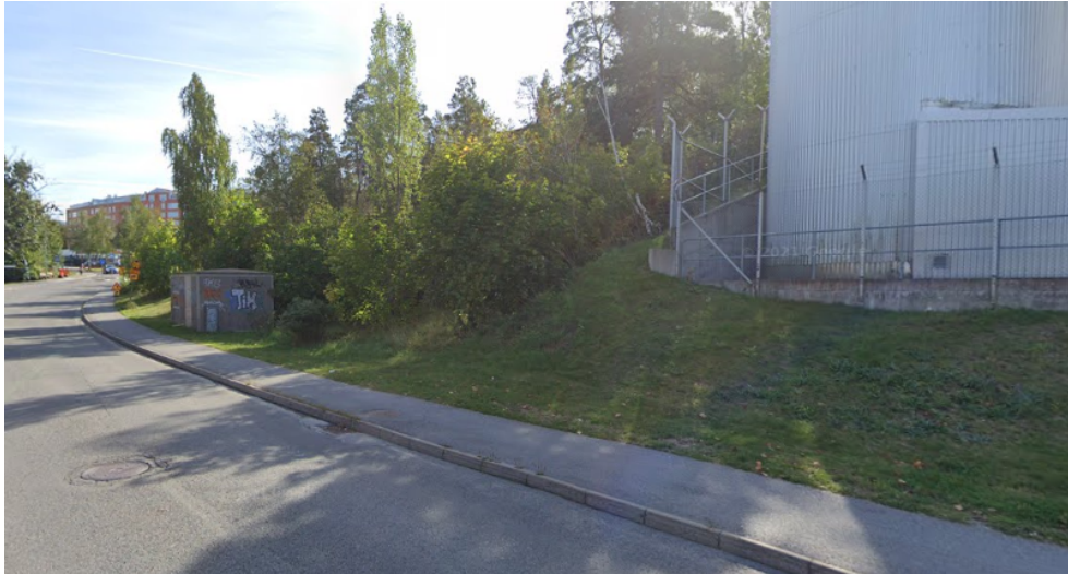
Figur 2: Foto över föreslagen placering av ny och befintlig nätstation.
