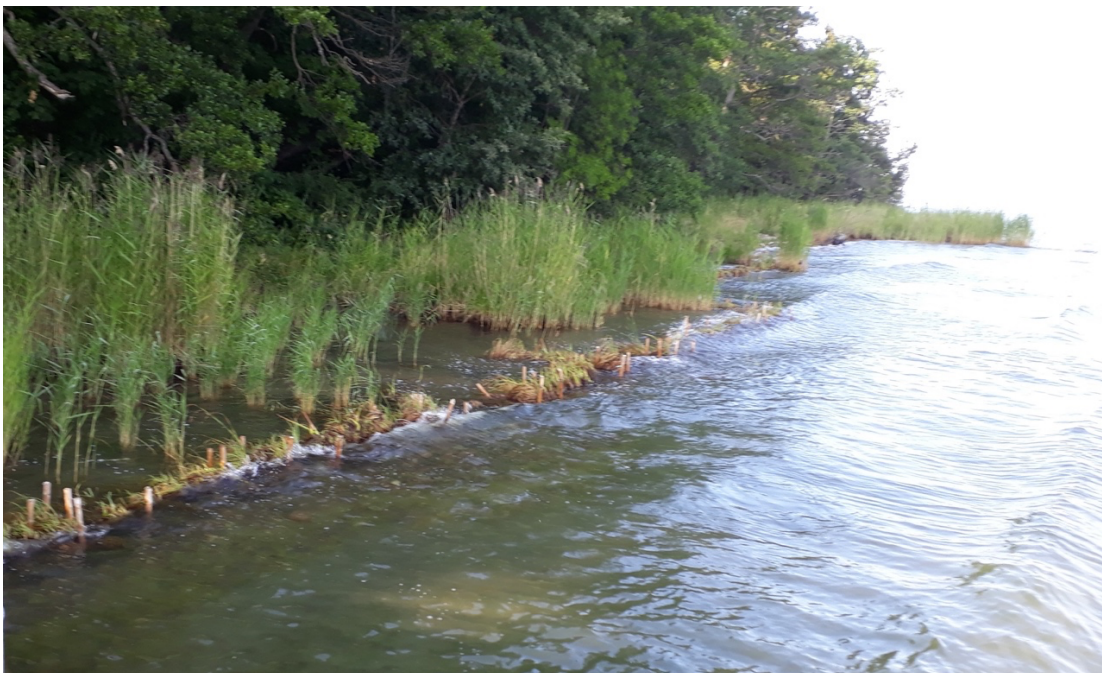
Fig 5: Uppflikad vass innanför erosionsskydd (som var intakta fem veckor)
