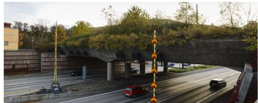
Figur 23. Genom att skapa ekodukter över vägar och järnvägsspår med mycket trafik gynnas en mängd olika arter. Åtgärden bedöms även som mångfunktionell då den gynnar friluftslivet med förbättrad rörlighet och minskad barriäreffekt. Foto: Johan Pontén (Miljöförvaltningen).
