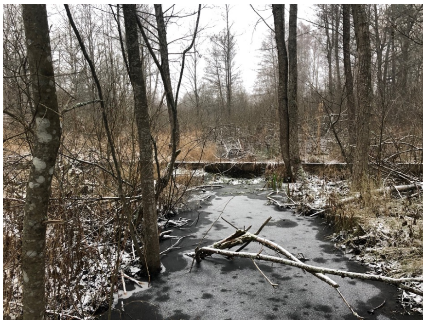
Figur 10. Flatendiket från söder mot norr från gångbron över diket. Foto från DHI (2018).
