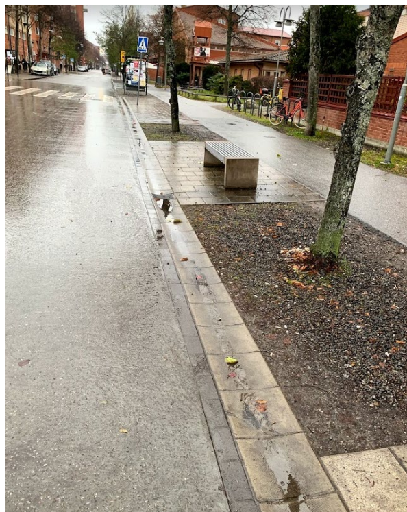
Figur 3. Befintliga växtbäddar för träd längs med Skarpnäcks allé för avrinning från väg- och gångbana. Foto Åsa Andersson 2019-11-12.
