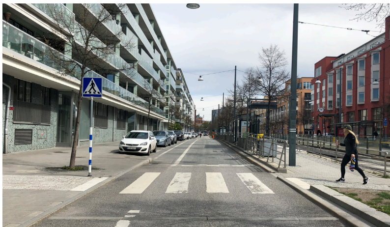
Båtbyggargatan vid Lugnets Allé, riktning österut.
