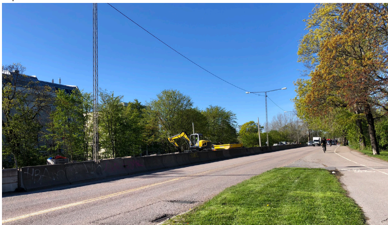
Johanneshovsvägen vid Bolidenvägen, riktning söderut.
