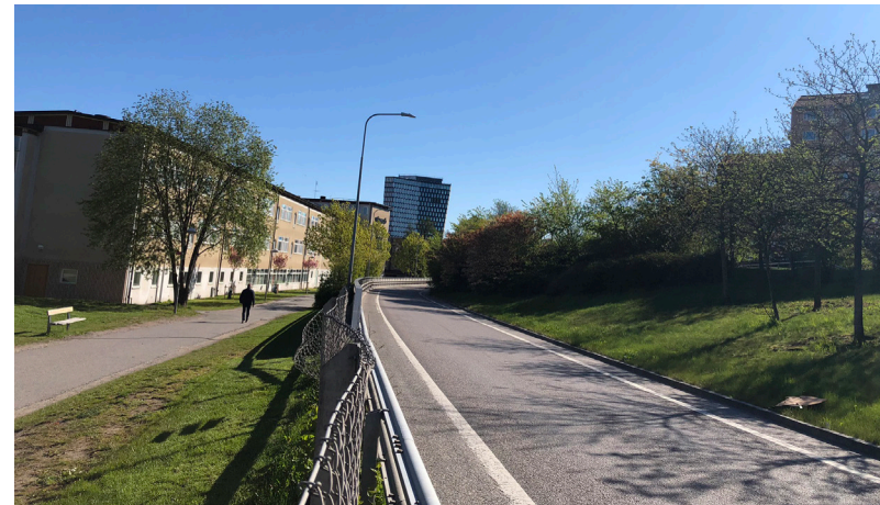
Johanneshovsvägen vid planskilda Gullmarsvägen, riktning österut.
