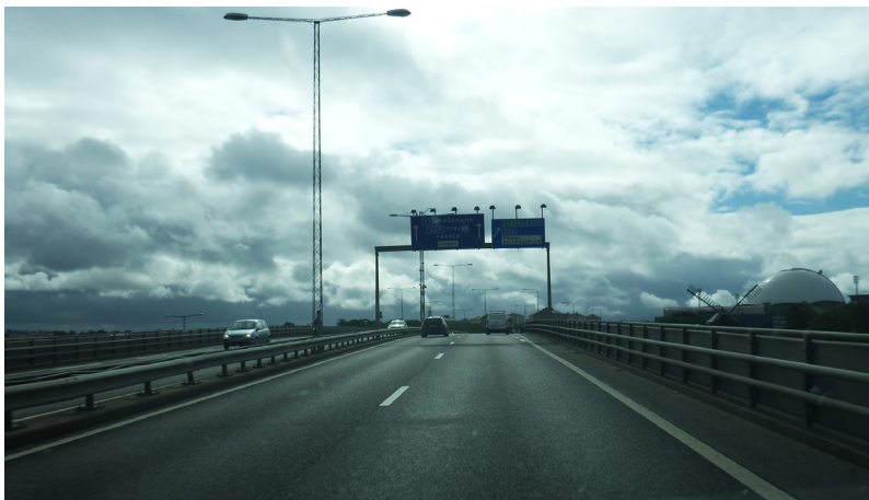
Johanneshovsbron, riktning söderut.
