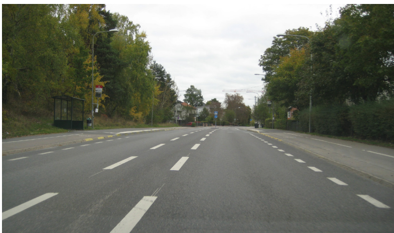
Grycksbovägen vid Söråkersvägen, riktning österut.
