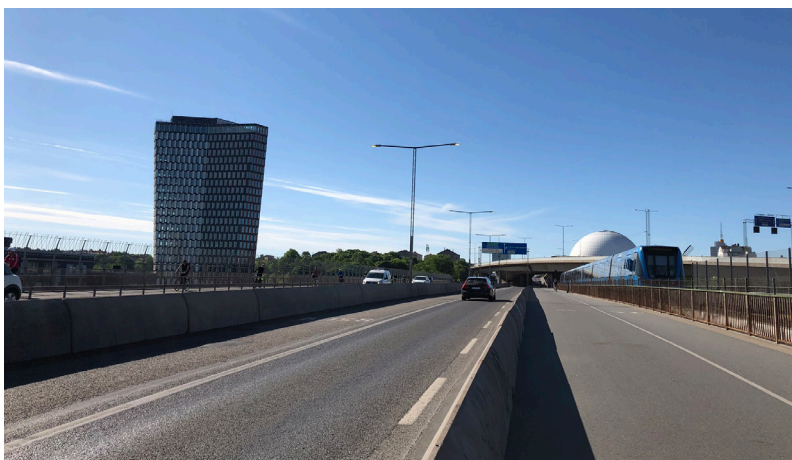
Skanstullsbron, riktning söderut.
