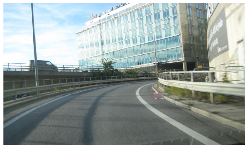
Södergatskopplet, riktning norrut.
