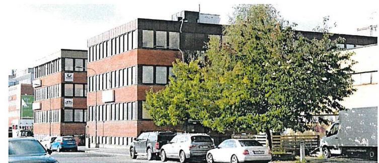
Bevarandevärda kontorsbyggnader längs med Sorterargatan.
