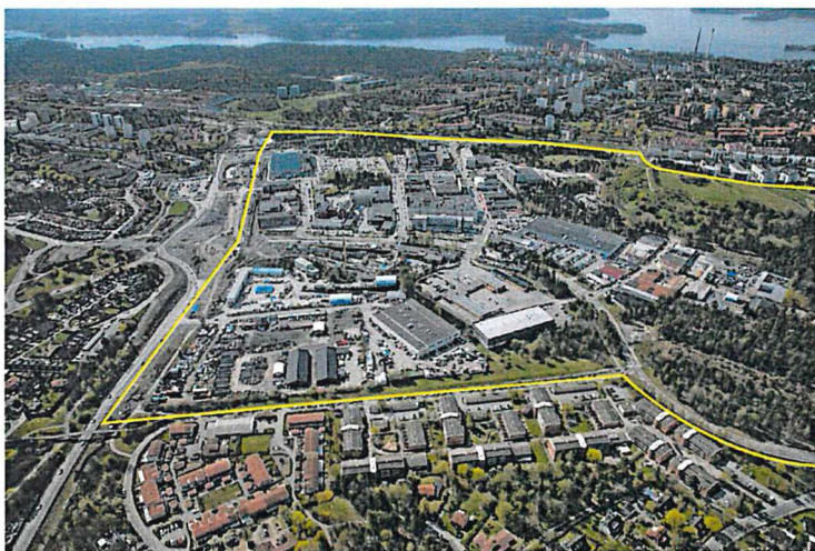
Flygvy över Vinsta-Johannelund sett från norr. Överst till vänster i bild syns Vällingby centrum och bortanför det Grimsta naturreservat. Överst till höger syns Hässelby. Närmast i bild syns bostadsbebyggelsen i Vinsta.
