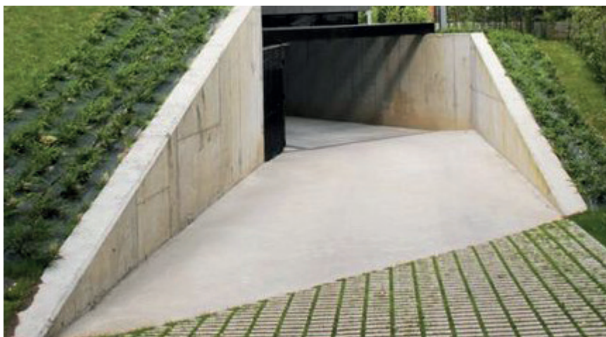
Exempelbild som visar öppen nedfart i betong.
