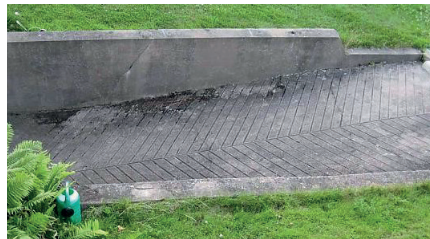
Exempelbild som visar öppen nedfart i betong.
