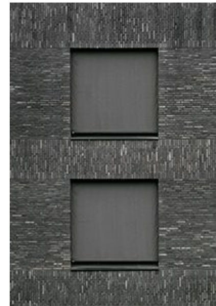
Fasad med band av stående rullskift.
