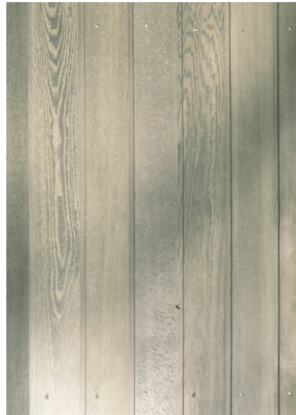
Fasad mot gård i värmebehandlad trä.
