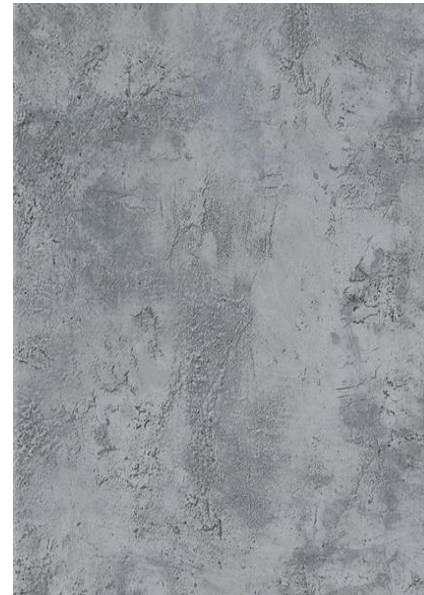
Loftgång och balkongplattor i betong.
