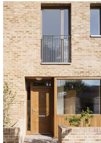
Fasad i tegel med träbeklädd entré.
