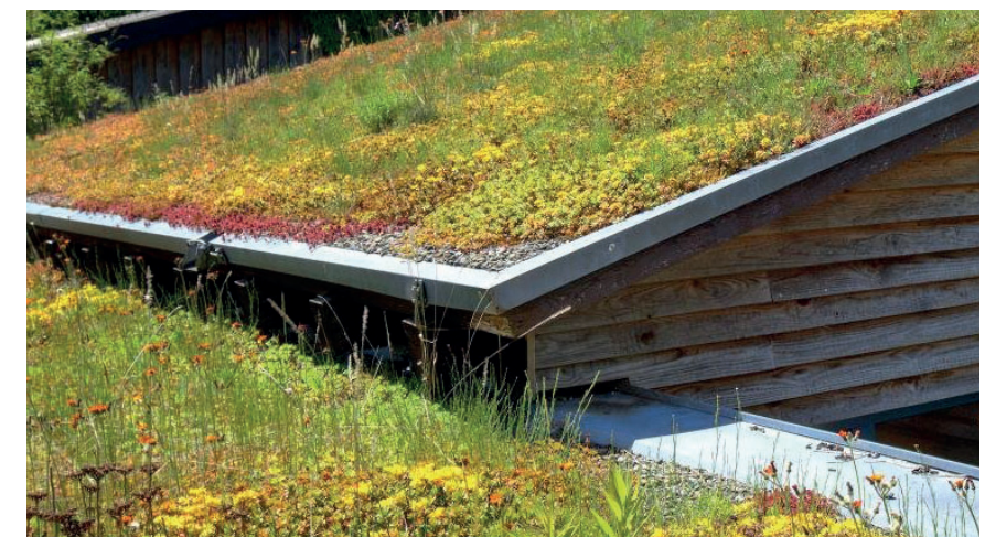
REFERENSBILD GRÖNT SEDUMTAK
