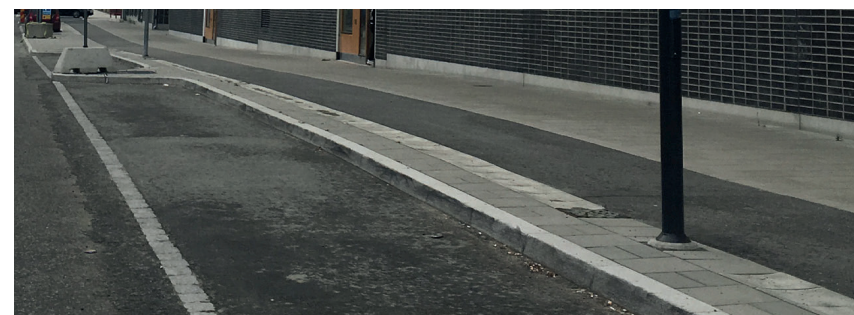
Körbana, parkeringsfickor och cykelbana i asfalt. Kantsten i granit. Bild: SWMS
