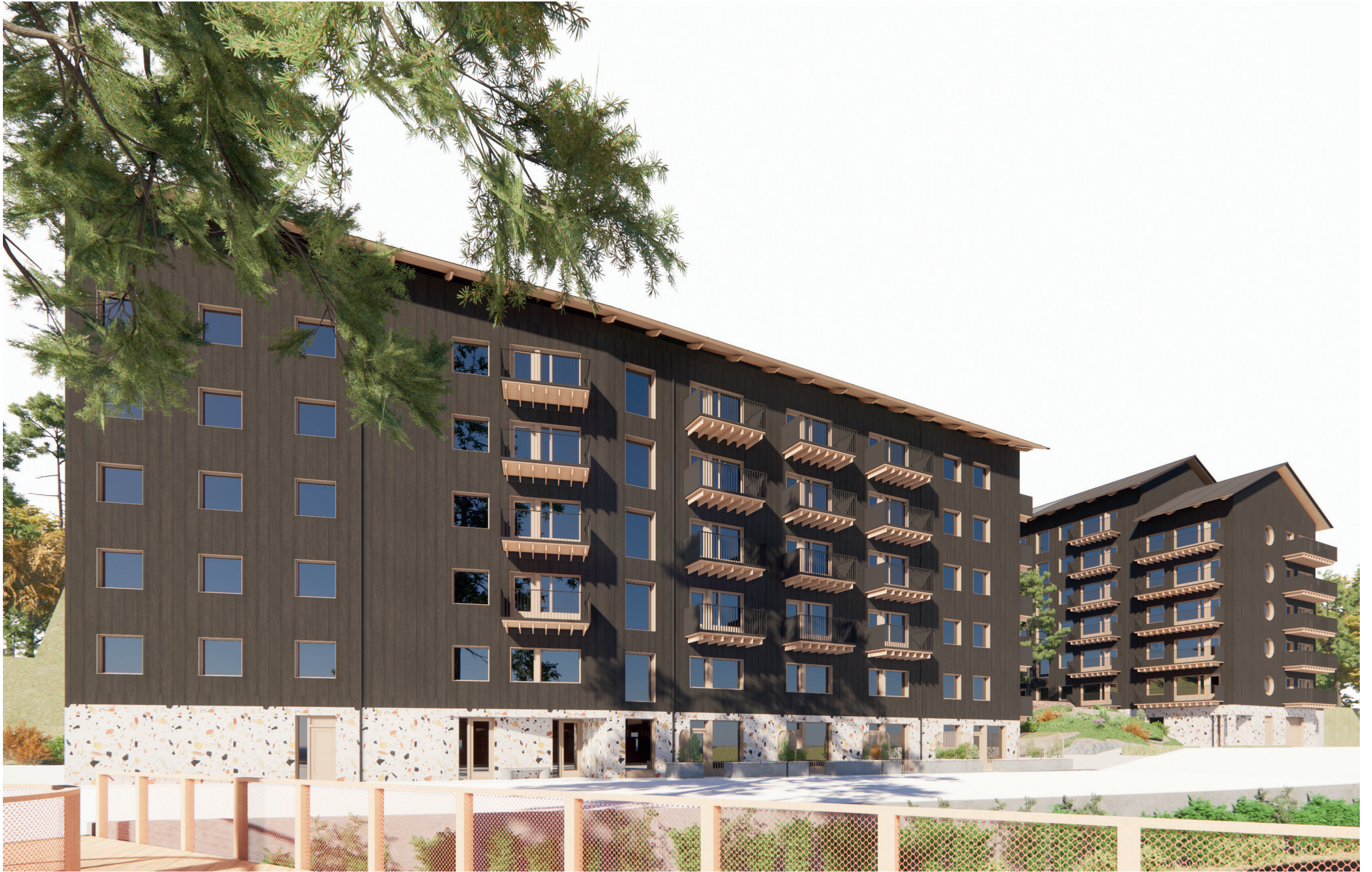
VY MOT 'STIGS' SYDÖSTRA FASAD
