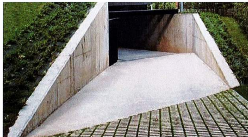
Exempelbild som visar öppen nedfart i betong.
