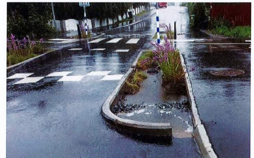
Exempel på välfungerade raingardener för lokalt omhändertagande av dagvatten i vägmiljö, Öringevägen i Tyresö.
