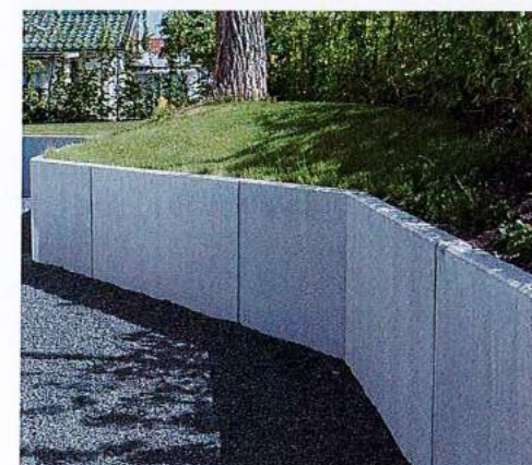
Låga stödmurar mellan uteplats och golfbana
