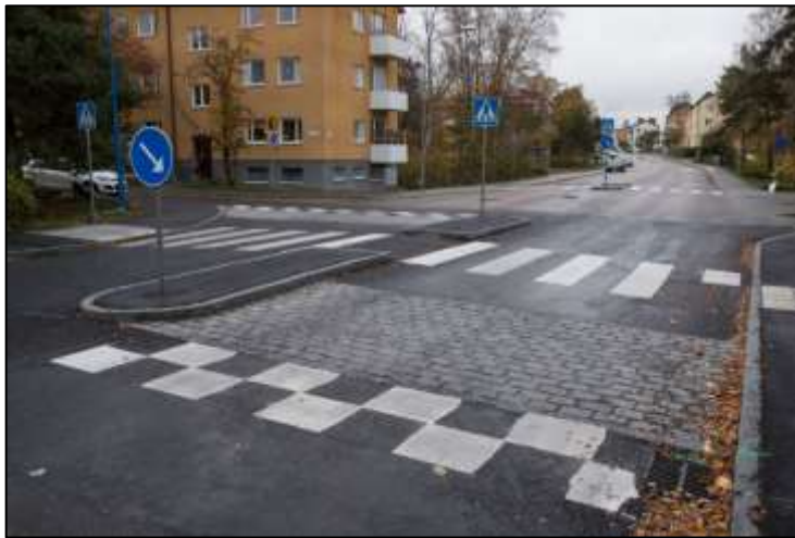
Bild 3, upphöjt övergångsställe med refug och påfartsramp samt lång nedfartsramp.
