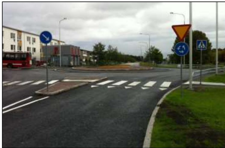
Bild 6, cirkulationsplats med ej överkörningsbar rondell.
