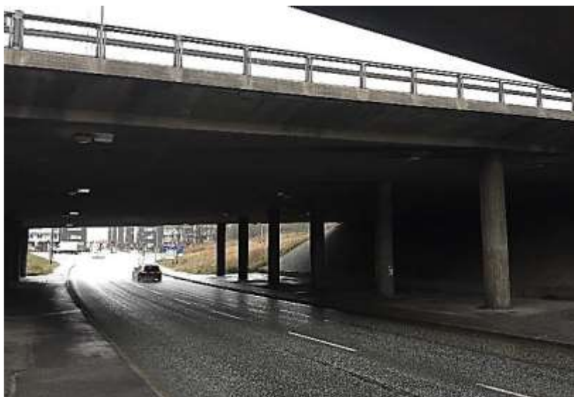
Figur 5. Gamla Tyresövägen i viadukten
