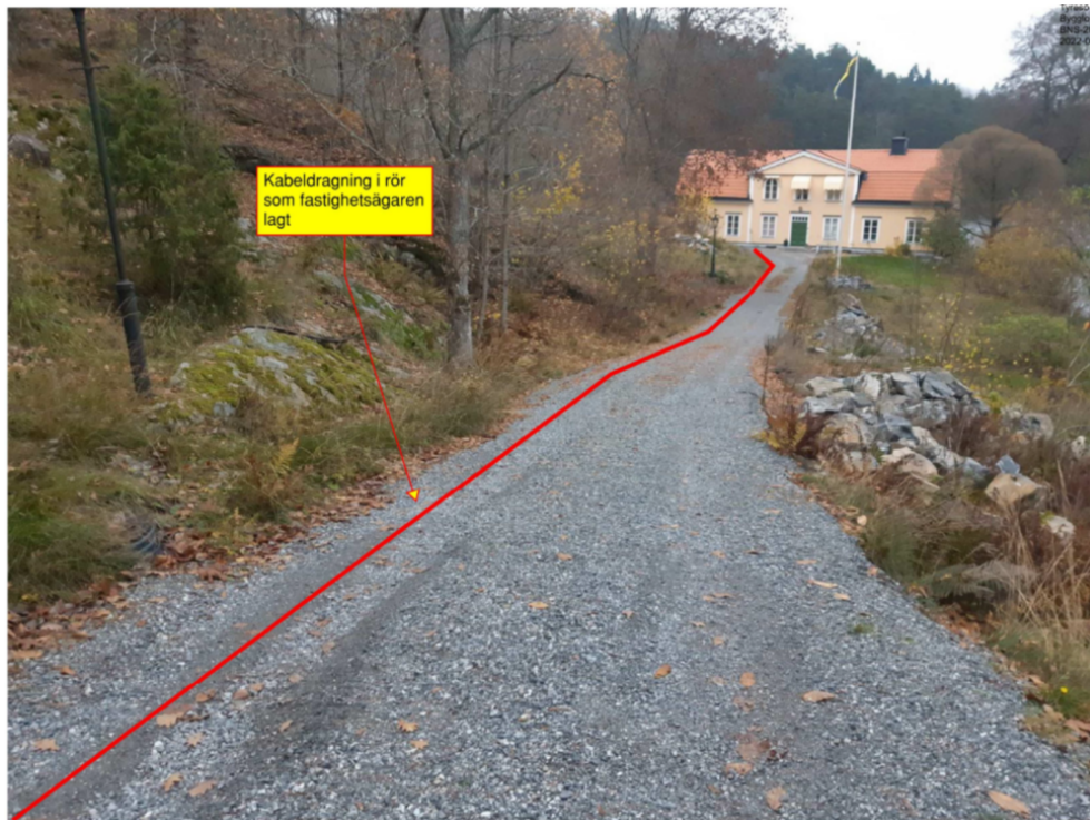
Figur 8 sträckning av ny markledning i befintliga rör under mark
