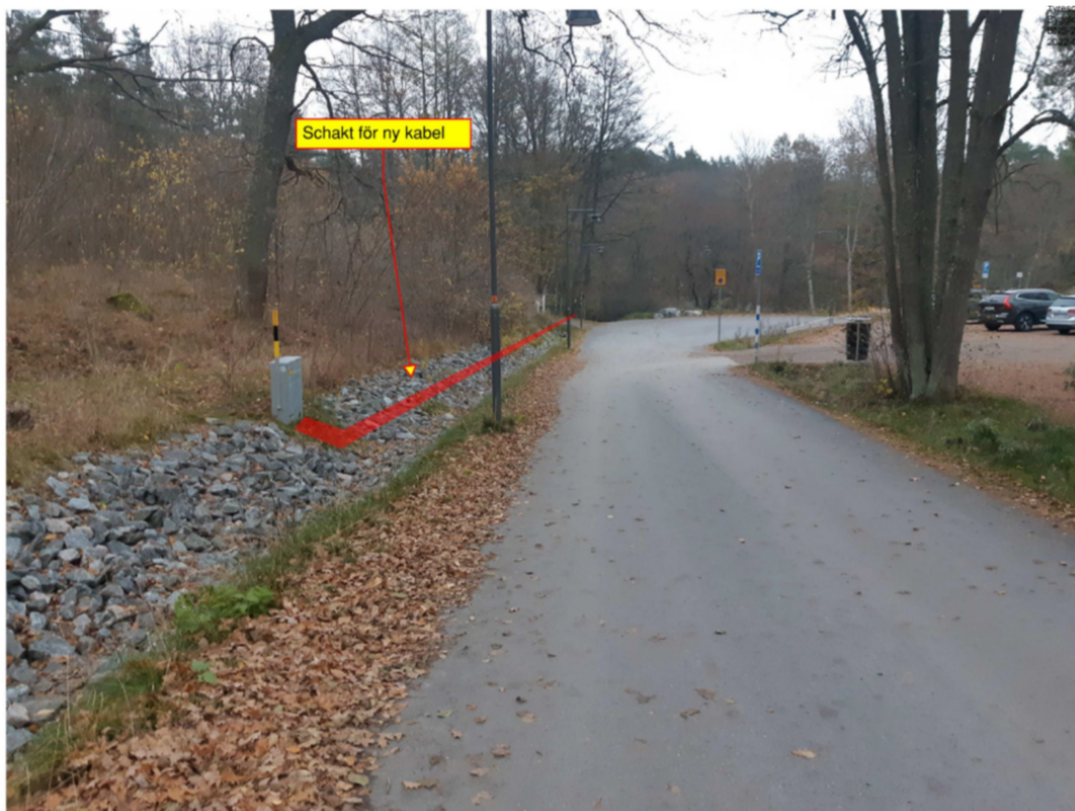
Figur 4 kabelskåp och sträcka för planerad schaktning
