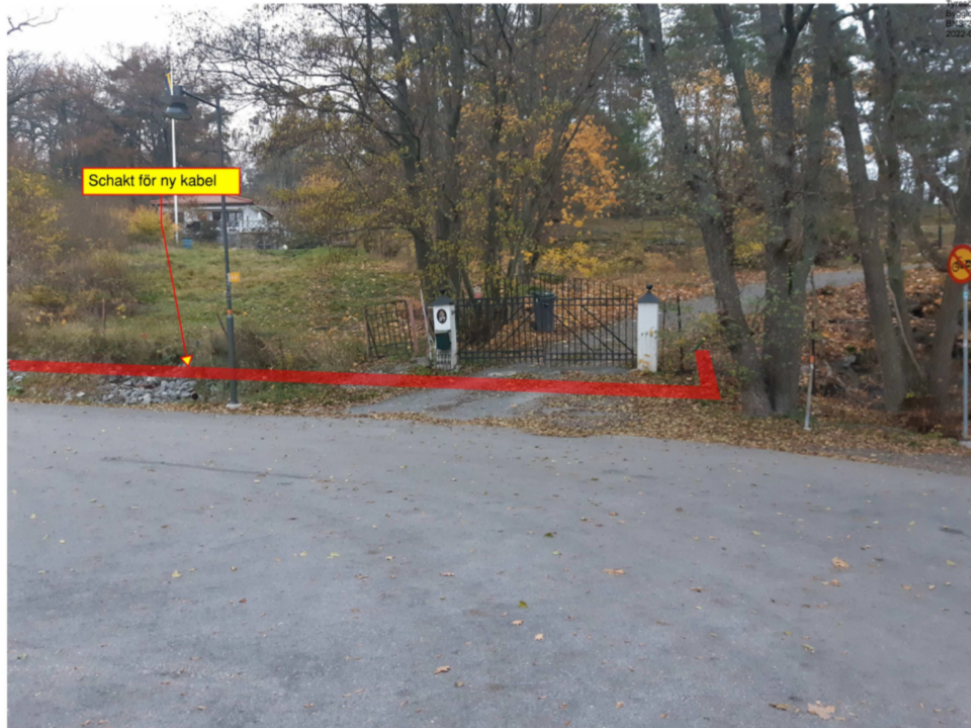
Figur 5 planerad schaktning fram till fastighetsgräns
