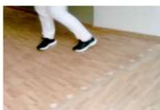
Mindre bra med runda och alltför ljusa nivåskillnadsmarkeringar som bör vara heldragna i kontrastfärg
