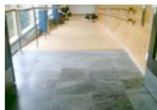
Ny ingång från entréhallen med bra ramp i avfasade sektioner
