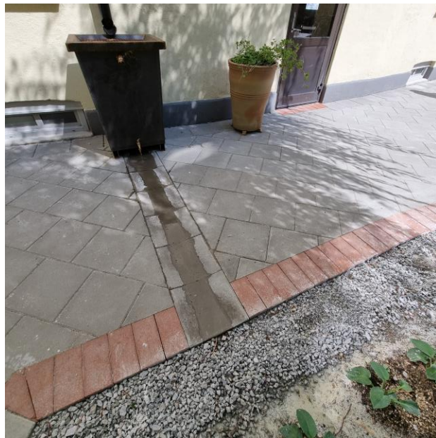
Fig.15 Dagvattentunna med öppen kran i Möllevången, Malmö. Vattnet leds till plantering.
