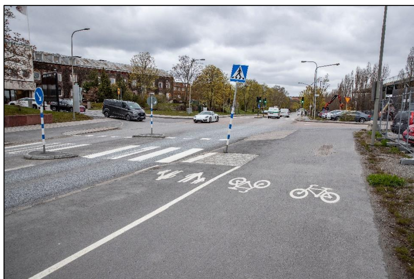
Figur 4, befintlig cykelbana på östra sidan om gatan.
