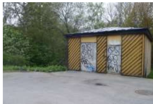
Figur 2: Fotografi på den befintliga byggnaden, (fläktrum)
