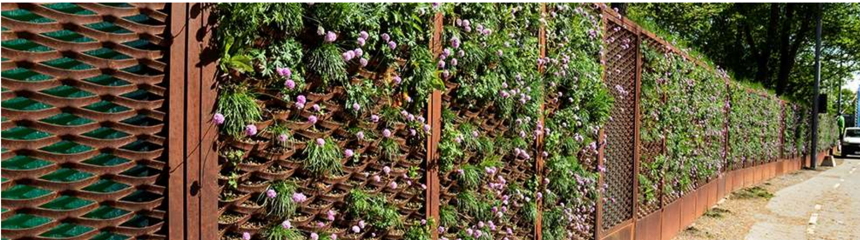
Figur 11. Anläggning av växtväggar, även kallade "gröna väggar", kan med rätt utformning och växtval gynna pollinatörer och förslagsvis anläggas dessa integrerat som bullerdämpning intill vägar. Exempel från Lidingövägen. Foto: Johan Pontén.
