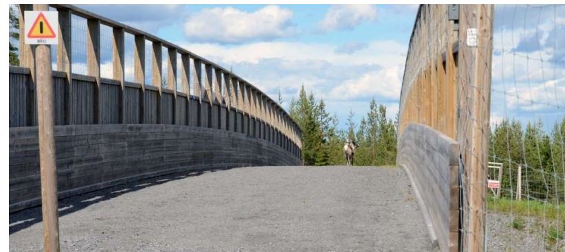
Figur 25. Enklare faunabro i trä som kan kompletteras med växtlighet i form av planteringar. Foto: Trafikverket.
