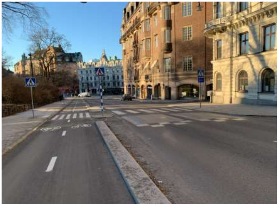
Bild 4: Fotografi som visar Engelbrektsgränd efter ombyggnaden, med en granitsten som refug och avskiljare mot motorfordonstrafiken.
