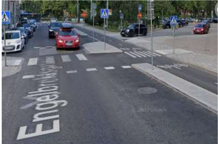
Bild 8: Fotografi som visar Engelbrektsgränd efter ombyggnaden, med prefabricerade refugelement som avskiljer cykelbanan från motorfordonstrafiken.
