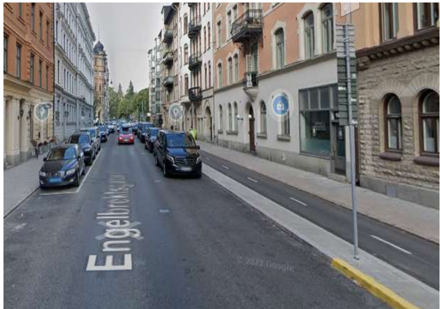
Bild 9: Fotografi som visar Engelbrektsgränd från Östermalmsgatan och mot Valhallavägen efter ombyggnaden. Med prefabricerade refugelement som avskiljer cykelbanan från motorfordonstrafiken.
