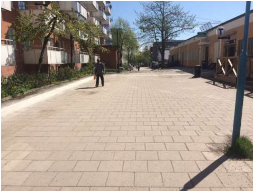
Bild 12 Tunnelbanetorget's stora öppna yta med betongplattor före ombyggnation.
