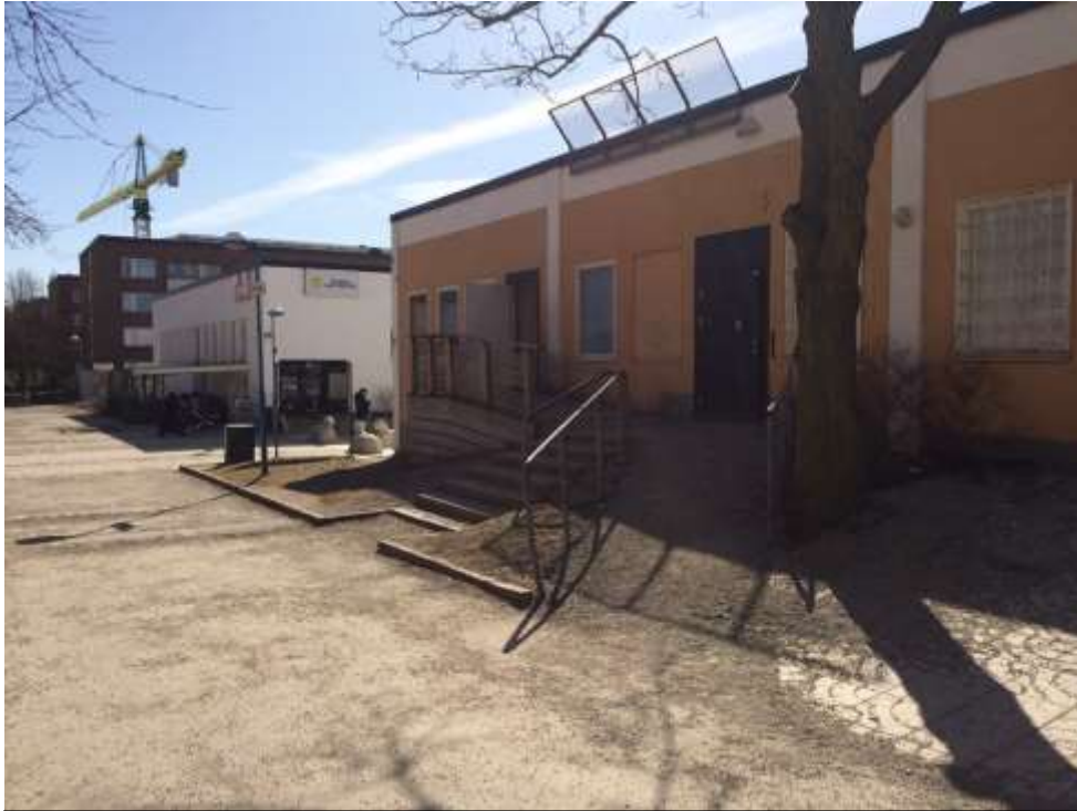
Bild 10 Den gamla höjdsättningen mot Fastpartners fastighet.
