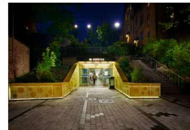
Ropstens tunnelbanestation, Stockholm.
