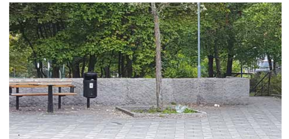
Befintliga granitmurar tas om hand och återanvänds för att ta upp terrassering mot Kvarnbyskolan.
