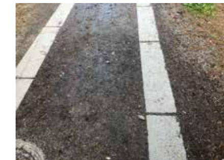
Gångar av stensmjöl med betongfris
