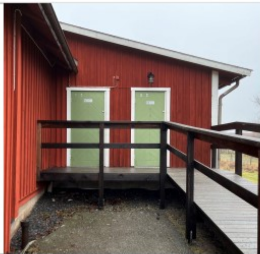
Tillbyggnaden mot öster (1988), med ramp till två allmänna WC.
