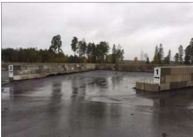
Bild 1: tom fack med betongblock
