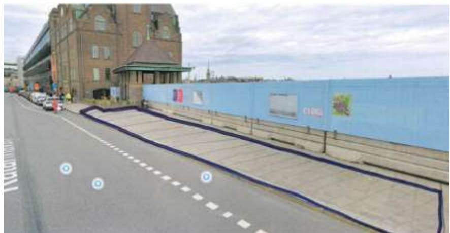
Figur 1: Fotografi som visar berörd del av Katarinavägen. Området markerat med blå begränsningslinje visar en ungefärlig utbredning av övergångskonstruktionen.
