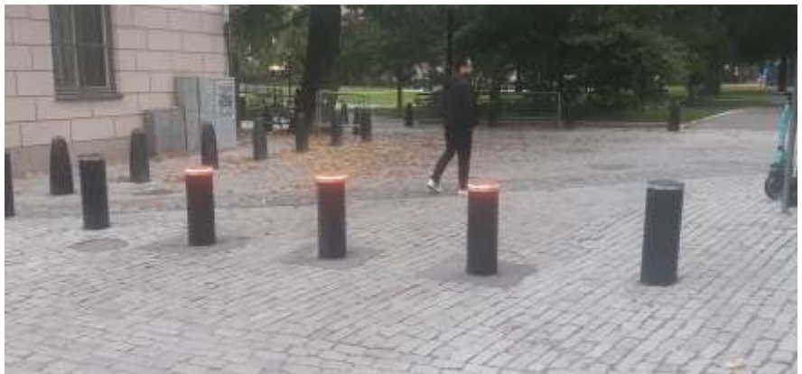
Bild 3. Fotograf som visar Wahrendorffsgatan vid Berzelii park efter ombyggnation med de tre rörliga pollarna i upphöjt läge.
