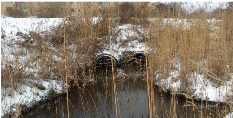
Kulvert under Spångavägen. Foto: Ekologigruppen
