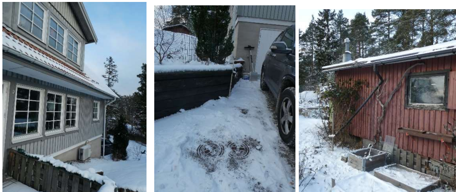
Figur 6. Foto av fastigheten; takavvattning befintlig byggnad och brunn till dagvattenservis (den andra brunnen är till spillvattenservis) samt avvattning av uthustak till växtbädd.(foto: E.Thunberg, 2021)
