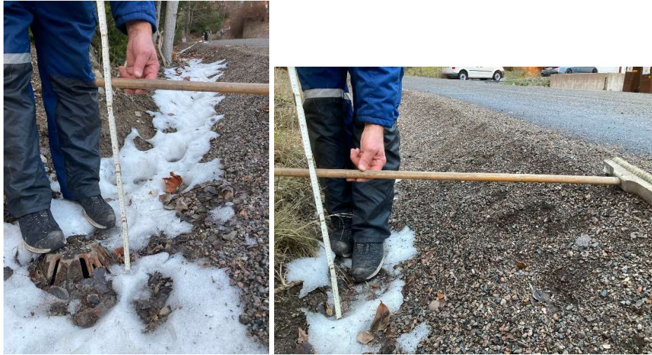
Figur 5 Foton på vägdike mellan Torparevägen och fastighetsgräns Bredablick 6. (foto: E.Thunberg, 2021)
