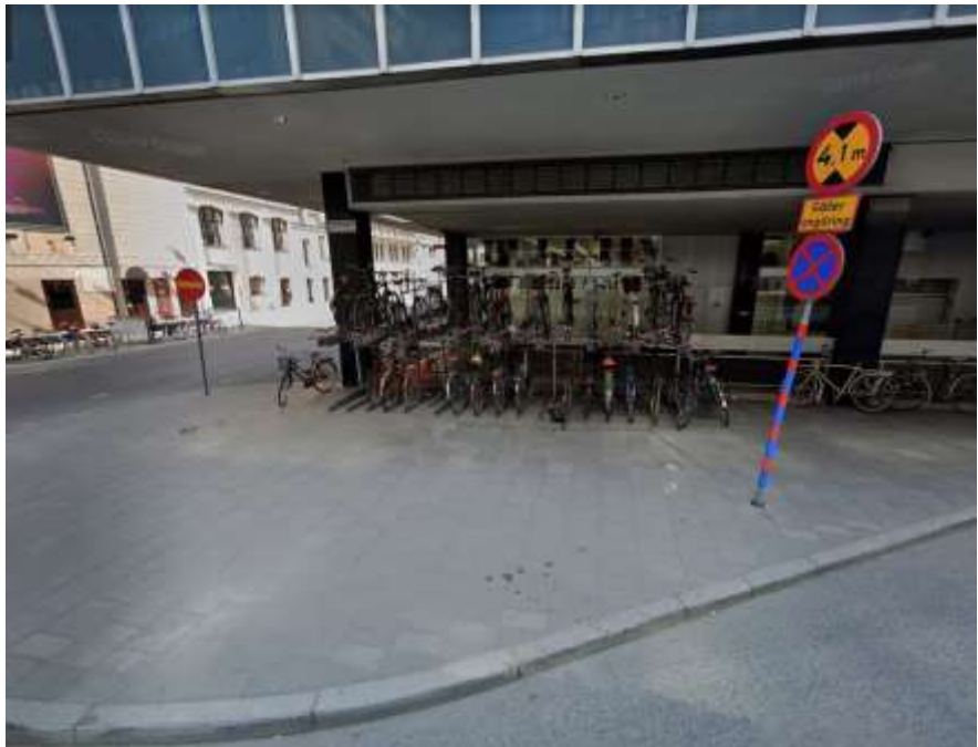
Figur 3. Tvåvåningsstall på Östra Järnvägsgatan med fastighet som väderskydd
