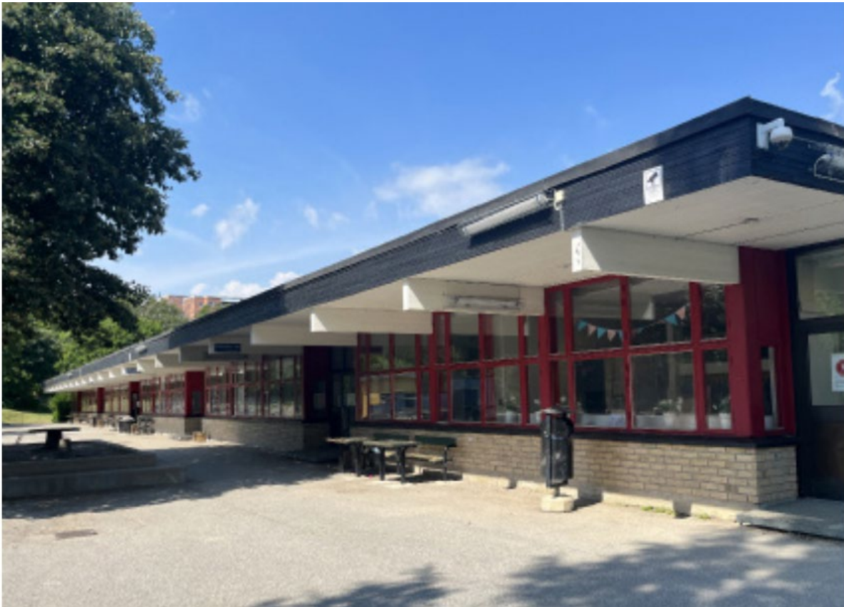
Figur 19. Fotografi på huvudbyggnaden sett från sydväst (AIX arkitekter).
