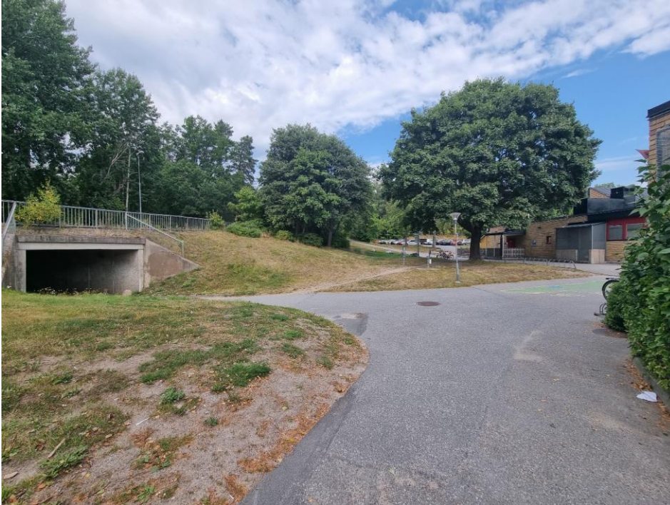
Figur C. Befintlig servispunkt för vatten, spillvatten och dagvatten återfinns vid den norra gångtunneln under Njupkärrsvägen. Området utgör en lågpunkt där vatten ansamlas vid extrema regn/skyfall.
