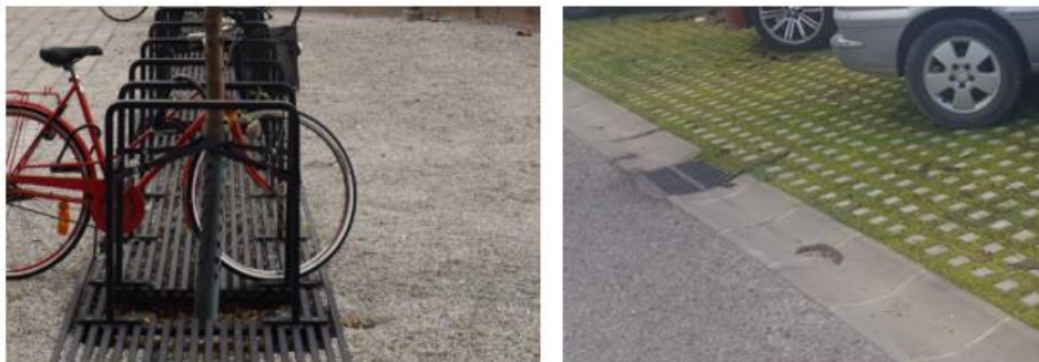
Figur 18. Exempel på genomsläppliga beläggningar på cykel- och parkeringsytor. Foto t.v.: VA-syd, foto t.h.: Sweco
