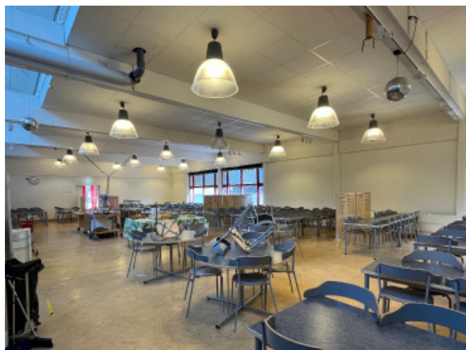
Matsalen har genomgått omfattande förändringar. Golv- och takbeklädnad är utbytt, samt ny inredning.
