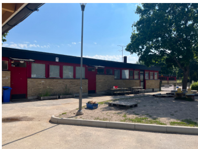
Förskoleavdelningens norra fasad. Den röda kulören återkommer även på dörrar.
