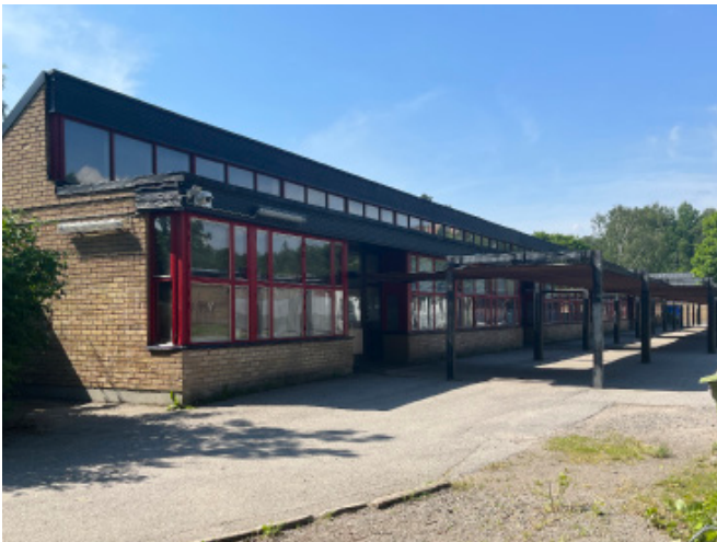
Det övre fönsterbandet ger dagsljus till klassrummen och bidrar till byggnadens skulpturala uttryck.
