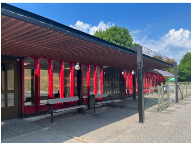
Regnskyddet i korrugerad plåt binder samman matsalsbyggnaden med huvudbyggnaden.
