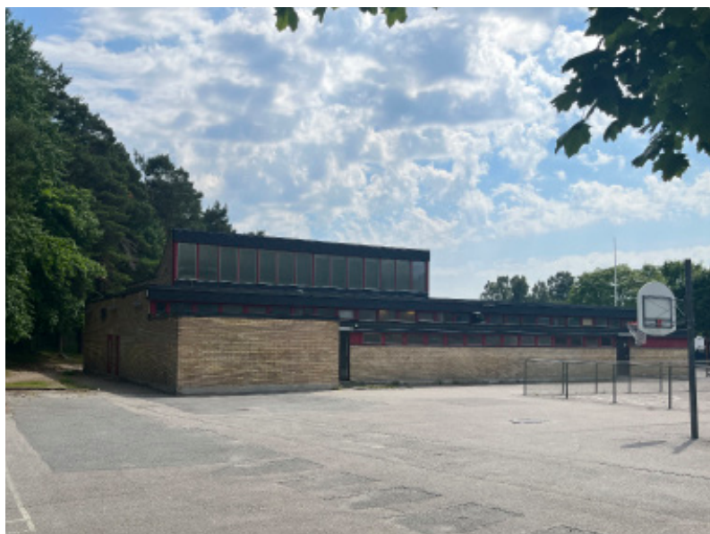
Gymnastikbyggnadens olika delar: korridor, omklädningsrum, gymnastiksal, markeras genom vardera fönsterband. Byggnaden får en växande volymverkan.
