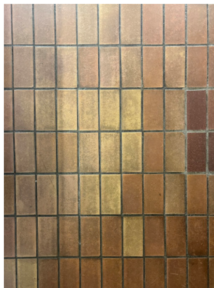
Ursprungligt klinkergolv i kapprummen.
