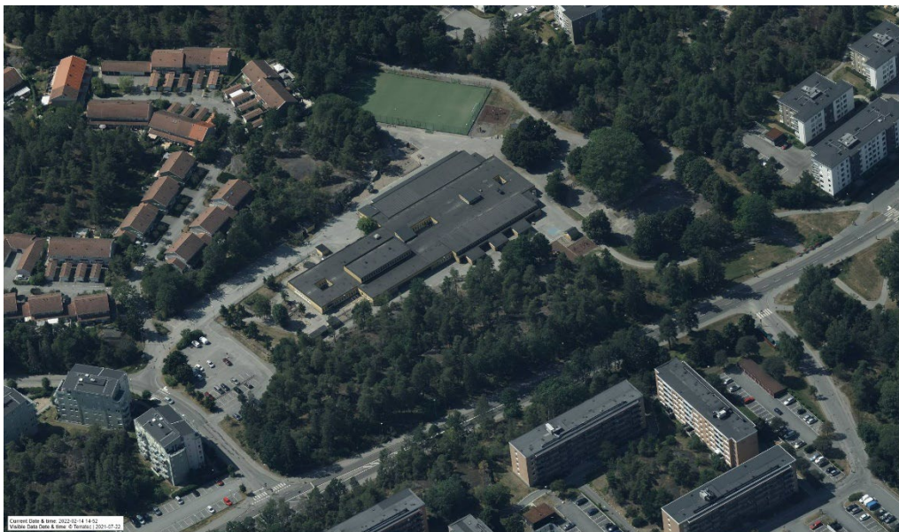
Figur 3. Ortofoto över fastigheten Näsby 4:1136 sett från öster (Mapspace).
