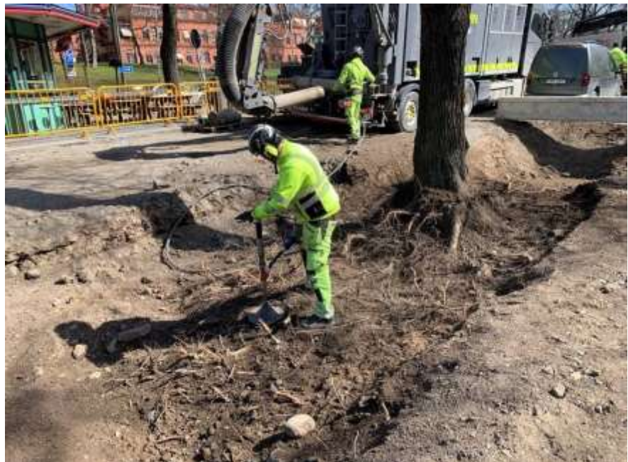
Figur 2: Gamla lindar på Valhallavägen sparas genom luckring av marken kring rötterna. Tryckluftslans och vakuumschakt används för att luckra upp marken samtidigt som skador på rötterna minimeras. Bilden är från Valhallavägen år 2021.
