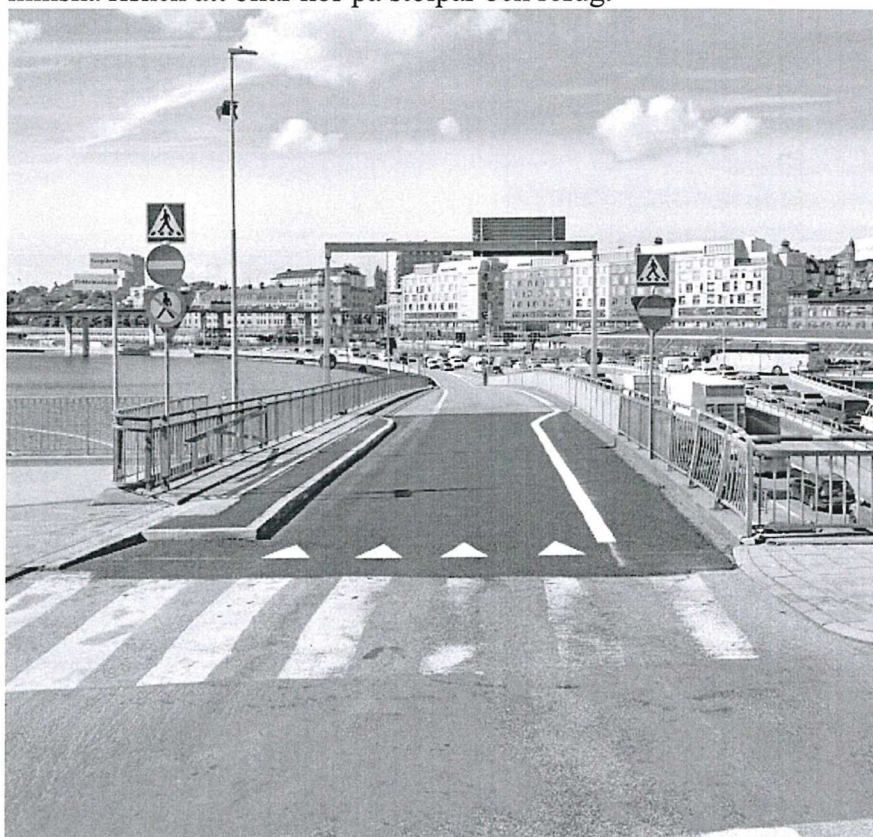
Ex 3: justering av körfält vid Västra Kungsbropkopplet, för att minska risken att bilar kör på stolpar och refug.
