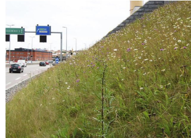
Färdig ängsmatta - erosionsskydd
