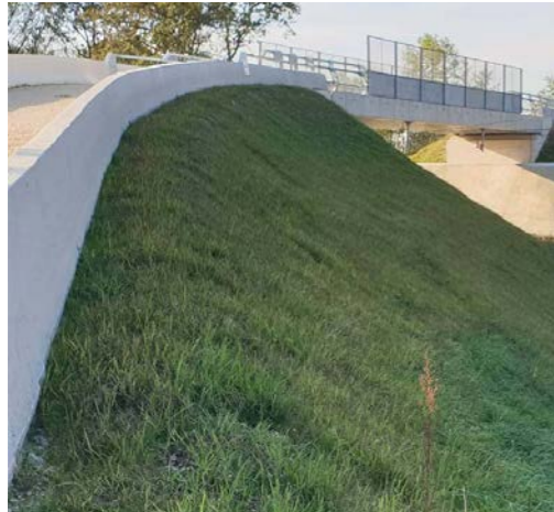
Hydroseeding med ängsfröblandning och mulch
