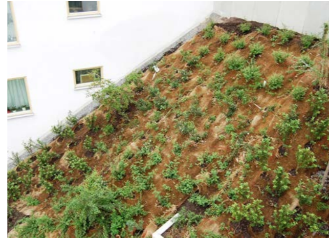
Kokosnät med buskplantering - erosionsskydd
