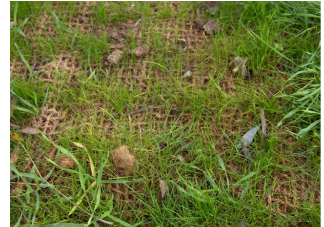
Sådd av ängsfröblandning med kokosnät
