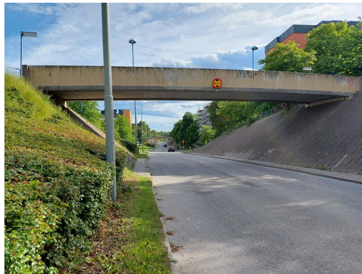
Västra slänten med glacis av betongplattor, östra sidan med buskage av häckoxbär
