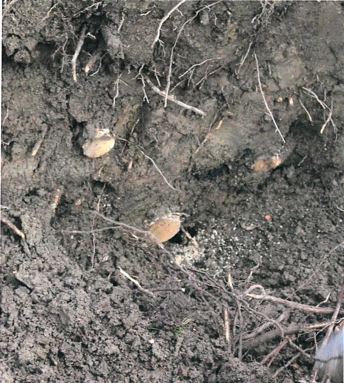
Bild 4. Korrekt beskurna rötter vid schakt.
