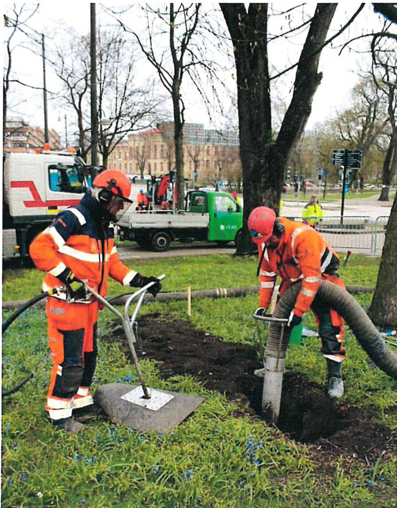
Bild 2. Skonsam schakt med tryckluft och vakuumsugning nära träd.
