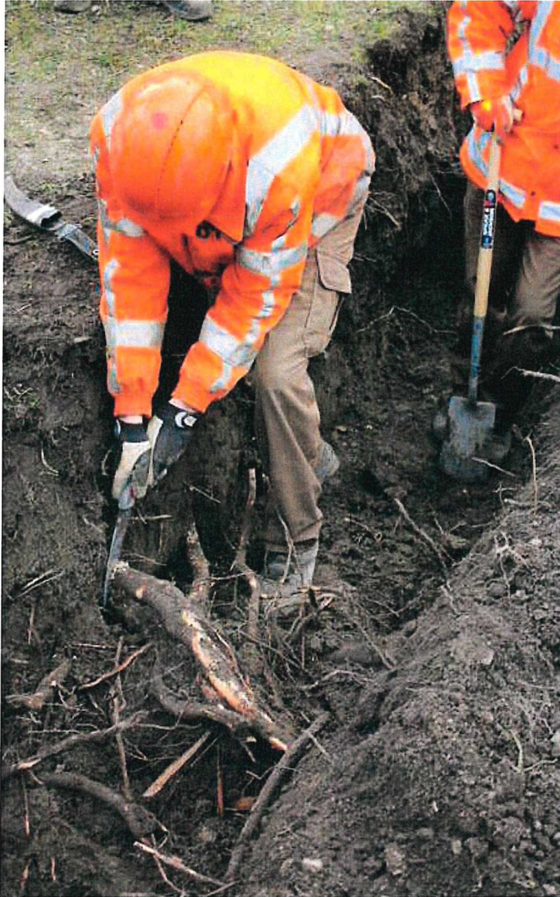
Bild 3. Trädrötter som måste avlägsnas vid schakt beskärs med beskärningsverktyg (handsåg).
