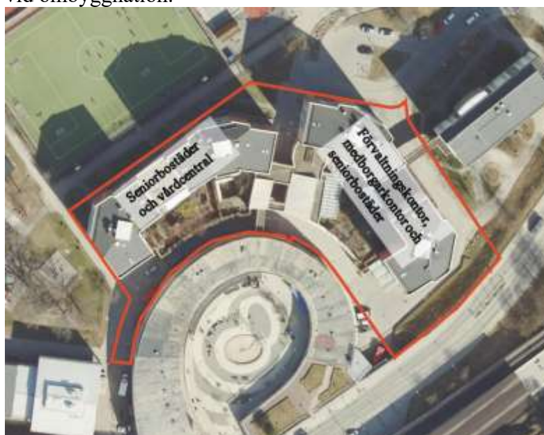
Micasas tomträttsfastighetsgräns markerat i rött. Preliminär ny fördelning av byggnadens användning redovisas i ovan texturutor.
