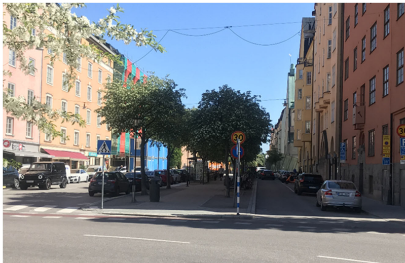
Figur 3. Vanadisvägen sedd från Vanadisplans rondell, består av en dubbelriktad körbana med parkering på båda sidor på norra sidan, en central allé med gångbana samt en lokal gata med parkering på södra sidan.
