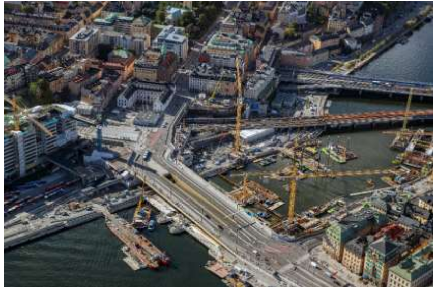
Bild 4: Pågående arbeten i Slussenområdet
