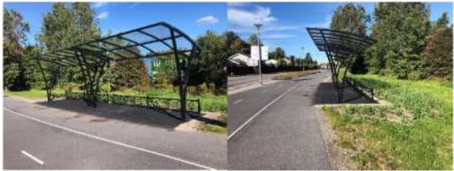
Bild 9. Framhjulshållare med väderskydd vid Bromstensvägen., 20 platser.
