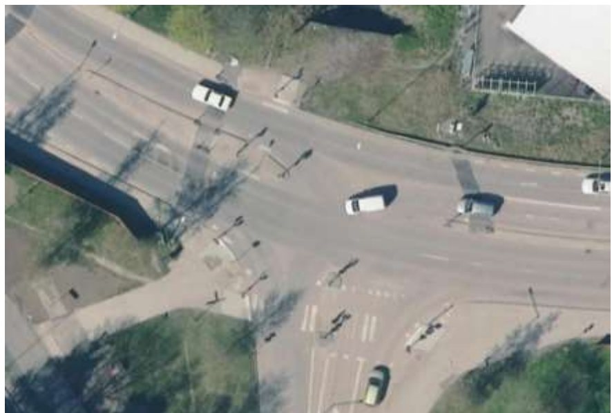
Bild 2. Flygfoto över korsningen Bromstenvägen/Gamla Bromstenvägen före ombyggnad. Cykelöverfart endast över Gamla Bromstenvägen och enkelt övergångsställe över Bromstenvägen.
