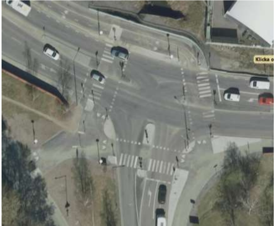
Bild 3. Flygfoto över korsningen Bromstenvägen/Gamla Bromstenvägen efter ombyggnad. Cykelöverfarten över Gamla Bromstenvägen har breddats och signalreglerade cykelöverfarter/övergångsställen ha anlagts över Bromstenvägen på bägge sidor om Gamla Bromstenvägen.
