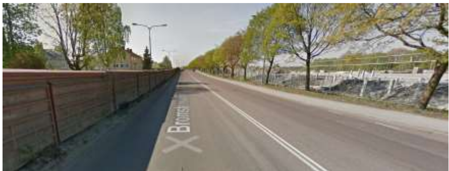
Bild 6. Gatuvy på Bromstensvägen i riktning mot Spånga station i höjd med Herdevägen före ombyggnad. Överbreda körfält och smal gångbana med träd i bakkant. Bygget av studentbostäderna pågår intill.
