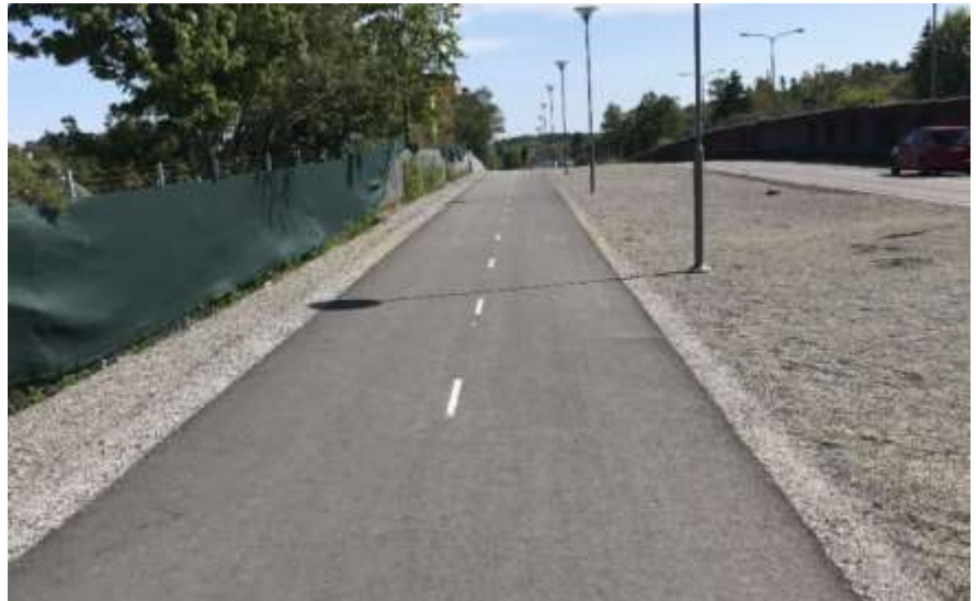
Bild 12. Fotografi på gång- och cykelbanan förbi pågående byggnation av studentbostäder i riktning mot Gamla Bromstensvägen i höjd med Logvägen, endast cykelbanebredden asfalterad i avvaktan på att exploatören bygger stödmuren.
