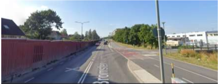
Bild 5. Gatuvy på Bromstensvägen i riktning mot Spånga station i höjd med Dalängsvägen efter ombyggnad. De överbredda körfälten har smalnats av och gett plats åt gång- och cykelbana med skiljeremsa mot körbanan. In- och utfarter har hastighetssäkrats med genomgående gång- och cykelbanor.
