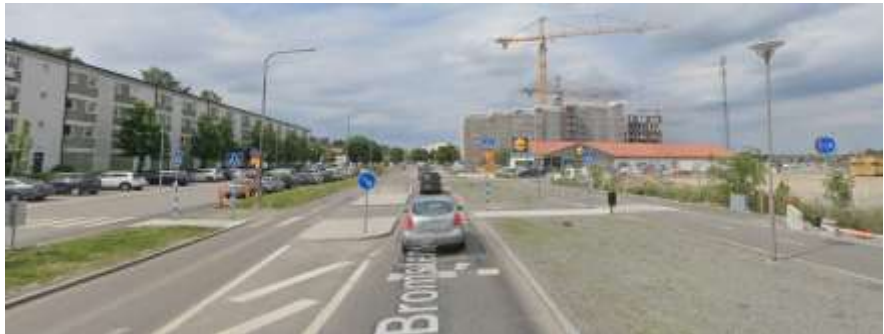
Bild 9. Gatuvy på Bromstensvägen i riktning mot Spånga station i höjd med Logvägen efter ombyggnad. De överbreda körfälten har smalnats av och gett plats åt gång- och cykelbana med bred gräsbesädd skiljeremsa mot körbanan. Det obevakade övergångsstället har hastighetssäkrats.
