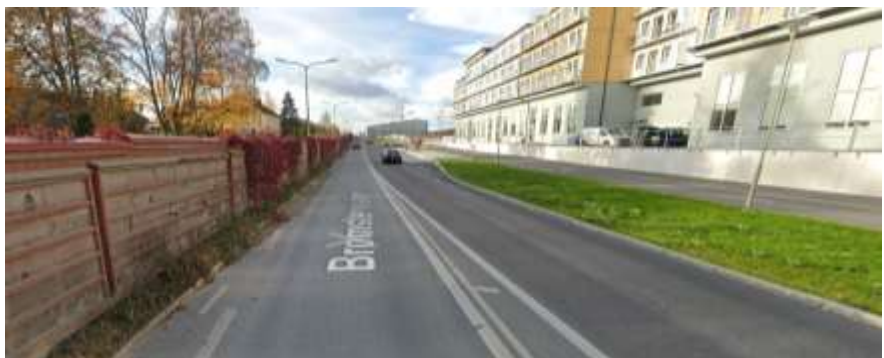
Bild 7. Gatuvy på Bromstensvägen i riktning mot Spånga station i höjd med Herdevägen efter ombyggnad. De överbredda körfälten har smalnats av och gett plats åt gång- och cykelbana med bred gräsbesädd skiljeremsa mot körbanan.
