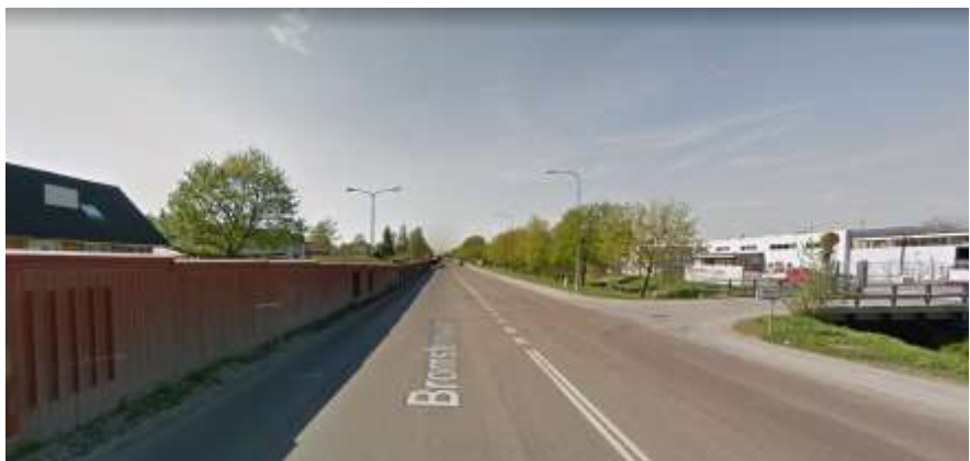
Bild 4. Gatuvy på Bromstenvägen i riktning mot Spånga station i höjd med Dalängsvägen före ombyggnad. Överbreda körfält och smal gångbana intill.
