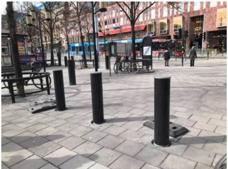
Bild 4. Korsningen Hamngatan – Kungsträdgårdsgatan. Totalt har tolv fasta pollare installerats vid plats 2.
