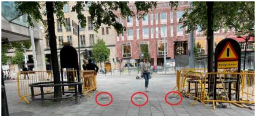
Bild 3. Korsningen Hamngatan - Jussi Björlings Allé. Tre pollare i nedsänkt läge. Totalt har tre rörliga och fyra fasta pollare installerats vid plats 1.
