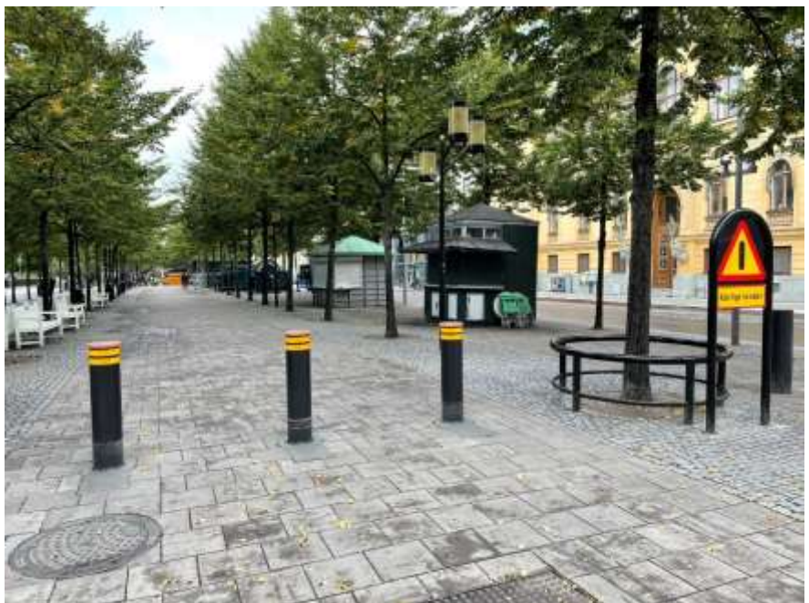
Bild 6. Entrén mitt emot Arsenalgatan. Tre pollare i upphöjt läge. Totalt har tre rörliga och fyra fasta pollare installerats vid plats 4.
