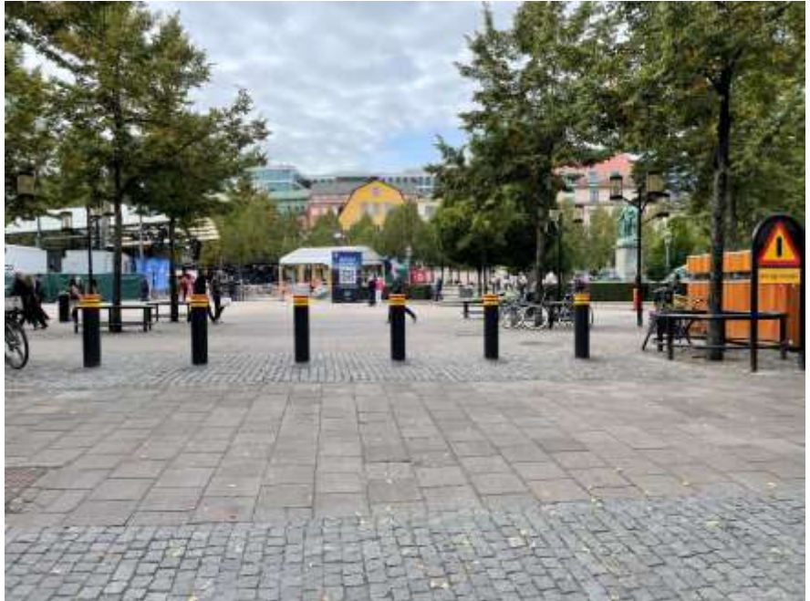
Bild 5. Entrén mitt emot Wahrendorffsgatan. Sex rörliga pollare i upphöjt läge. Totalt har sex rörliga pollare installerats vid plats 3.
