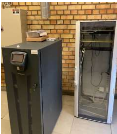
Bild 5. Nytt aggregat för avbrottsfri elkraft under installation.
