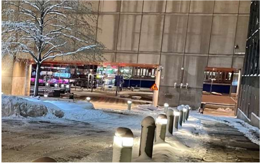
Bild 2. Snösmältningen fungerar inte pga. att markvärmerna är ur funktion på Benny Fredrikssons Torg.
