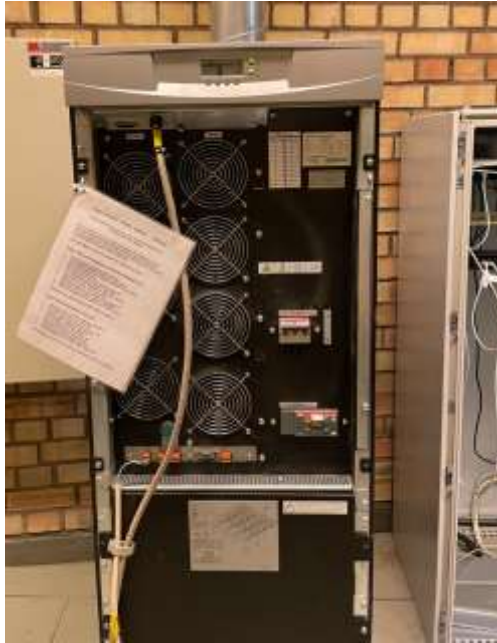
Bild 4. Gammalt aggregat för avbrottsfri elkraft under bortmontering.
