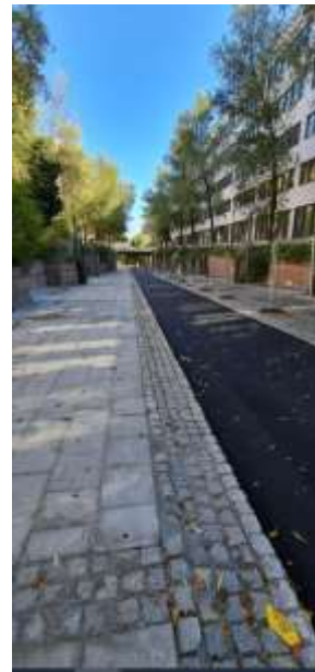
Bild 6. Bilden visar Södermalmsallén efter att markstenen har bytts ut mot asfalt för en bättre jämnhet och separation från gående.
