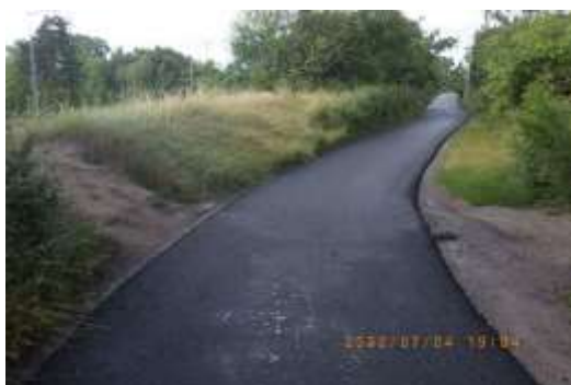
Bild 4. Cykelvägen längs Stamdikesvägen efter åtgärd. Sträckan har fått ny asfaltsbeläggning.
