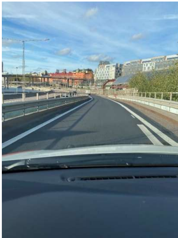
Bild 2. Klarastrandsleden, påfart Kungsbron norrgående efter åtgärd. Det översta lagret asfalt är bortfräst och ny jämn asfalt är lagd.
