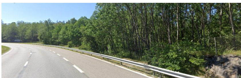
Figur 5 Vy över befintlig situation. Huddingevägen, södergående, mellan Grossistvägen och Glanshammarsgatan. (Google maps, juni 2020)
