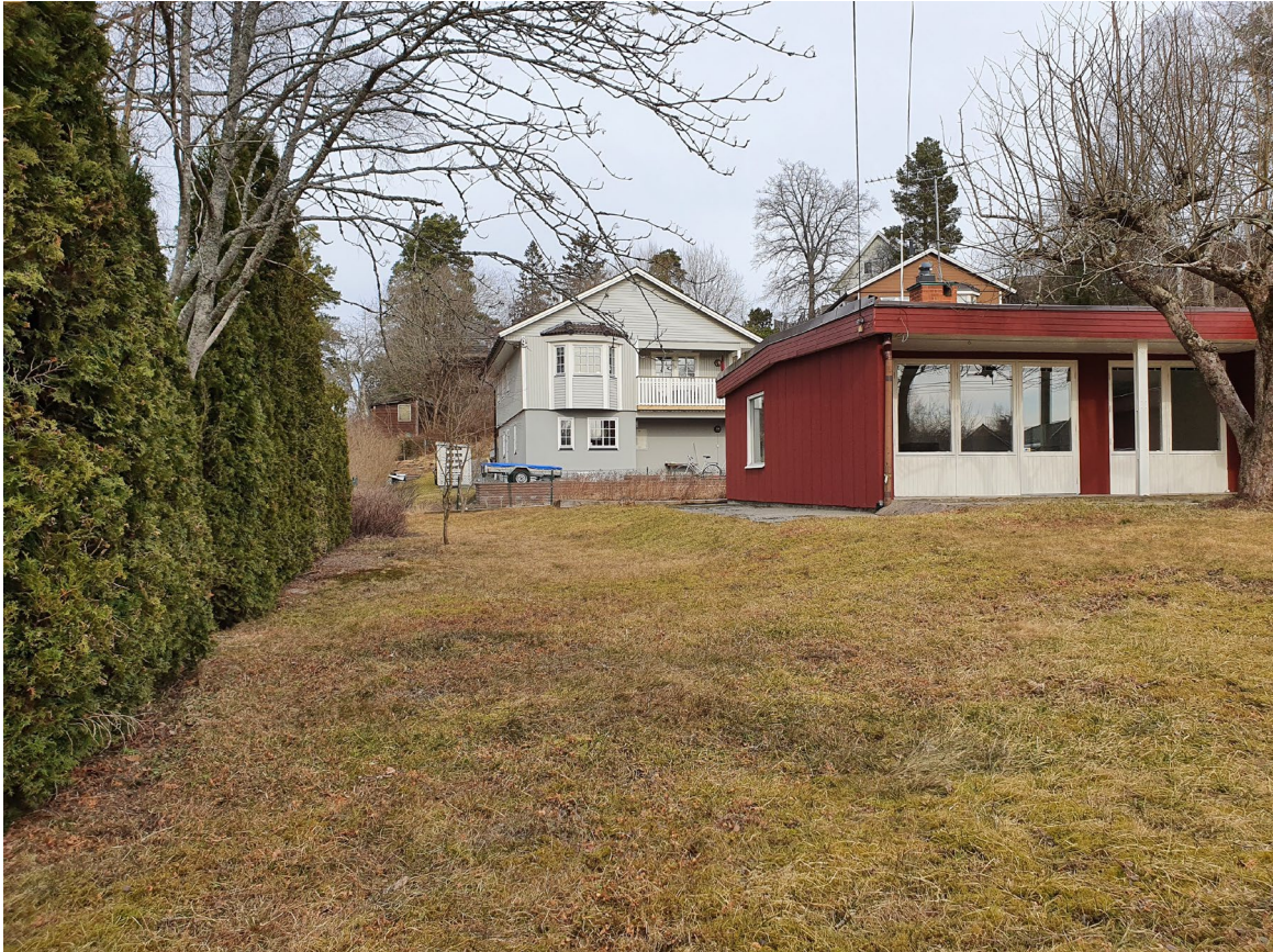
Figur 8: Fotografi från sydväst. Bild visar grannfastighetens huvudbyggnad (grå) och del av huvudbyggnad (röd) inom planområdet
